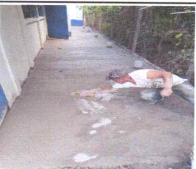
sustitución de torta de concreto
