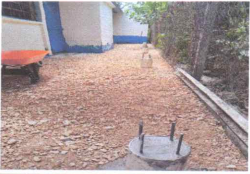
sustitución de malla galvanizada
