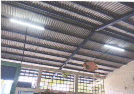
mantenimiento a cableado principal
