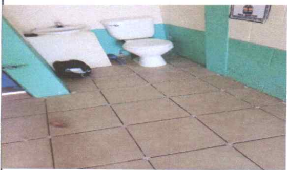
sustitucion de accesorios para inodoro
