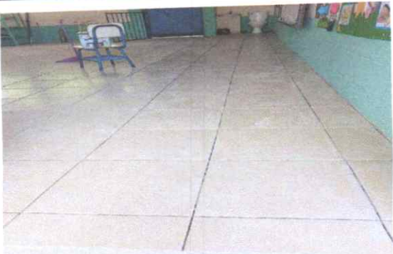
sustitucion de piso cerámico
